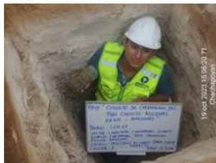
Trabajos de acondicionamiento (terreno)
